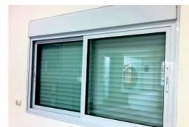
A aplicação de materiais pesados, como mantas de borracha de alta densidade, em **caixas de persianas automáticas** melhora a atenuação em 4 dB.
