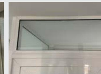
**Bandeira:** é um quadro posicionado acima da janela ou porta. Pode ser agregado para aumentar a entrada de luz no ambiente ou a integração entre ambientes sem sobrecarregar o sistema de abertura. Geralmente é fixo, mas pode ter aberturas como maxim-ar ou correr para ventilação.
