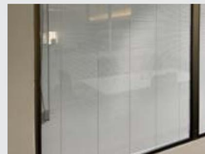
**Micropersiana entre vidros:** sistema de persiana especialmente projetado para ser instalado dentro da câmara de ar dos vidros insulados. Suas lâminas são finas e delicadas e seu mecanismo de controle permite ajustar o ângulo para controlar a entrada de luz e privacidade.
