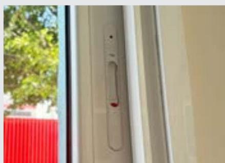
**Fecho concha com trava:** dispositivo de travamento em forma de concha que fica na folha (parte móvel) da janela ou porta e sua trava se encaixa no marco (parte fixa) da esquadria quando é acionado.
