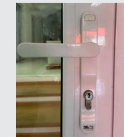
**Maçaneta e fechadura:** conjunto de dispositivos de manuseio e travamento de portas de giro. A maçaneta é a parte que o usuário aciona para abrir e fechar a porta. A fechadura é acionada por meio de chaves que permitem trancar ou destrancar a porta pelo lado interno ou externo.
