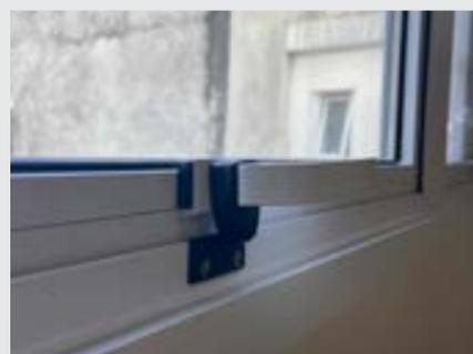
**Fecho maxim-ar pressão:** mecanismo de travamento projetado especificamente para janelas maxim-ar. Ao ser acionado, o fecho aplica a pressão necessária de maneira uniforme ao longo da estrutura da esquadria, garantindo assim um fechamento seguro e hermético nesse modelo de janela.
