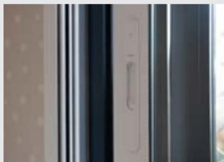
**Fecho concha cego / sem trava:** dispositivo de fechamento que fica na folha (parte móvel) da janela ou porta e permite seu manuseio. Não possui trava, sua função é unicamente permitir a abertura e fechamento da folha com os dedos. Utilizado nas esquadrias de sobreposição.
