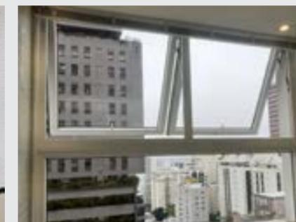
**Peitoril:** é um quadro posicionado abaixo da janela. Pode ser agregado para aumentar a entrada de luz no ambiente ou a integração entre ambientes sem sobrecarregar o sistema de abertura. Geralmente é fixo, mas pode apresentar aberturas como maxim-ar ou correr para ventilação.
