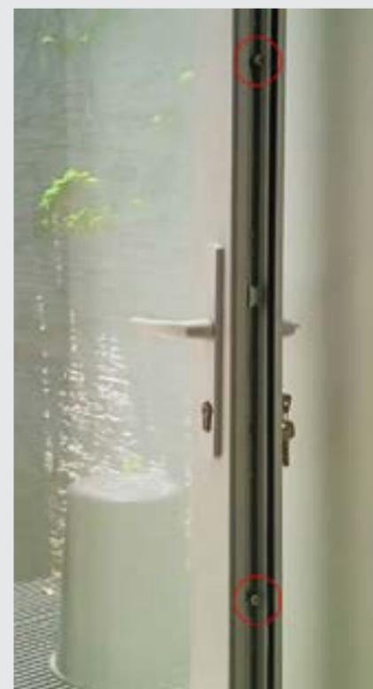
**Trava multiponto:** mecanismo de segurança que percorre a extensão da abertura, nas bordas da porta ou janela. Possui diversos pontos de travamento, geralmente três, que se engatam no marco da esquadria. Esses pontos de travamento são acionados simultaneamente pelo fecho.
