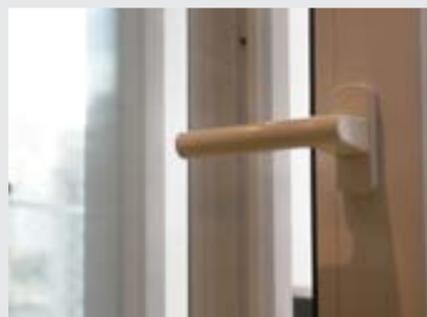
**Fecho cremona:** esse fecho possui uma alavanca na parte interna da janela ou porta, que estende por toda altura. Quando é acionado, a alavanca move uma barra de trinco vertical que se encaixa no marco (parte fixa), travando a folha (parte móvel) da esquadria em cima e embaixo.
